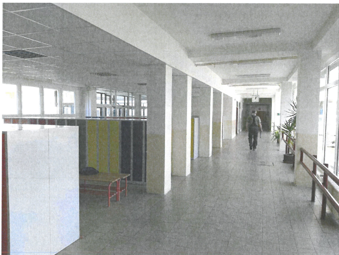
Foto č. 2 – Montovaný skelet S1.2 – pohled z interiéru
